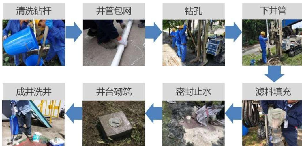
图 3.5-1 地下水监测井建设过程示意图
